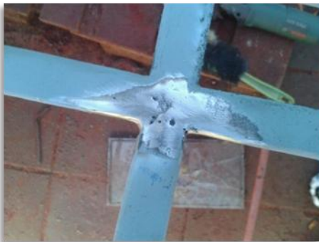
Viele Stellen mussten geschweißt werden
